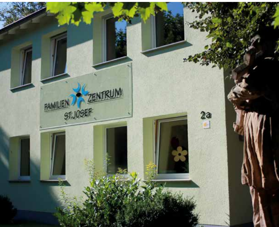
Die Gebäude der beiden Kitas in Bad Lippspringe (rechte Seite) und Schwaney wurden in den letzten Jahren saniert und baulich modernisiert. Fotos links: St. Johannes Baptist Foto rechts: Familienzentrum St. Josef
